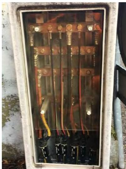
Cette armoire n'est pas équipée de réglettes avec fusibles permettant de protéger les bâtiments alimentés. Ainsi, s'il devait y avoir un défaut sur un câble, tous les consommateurs reliés à cette armoire seraient coupés. Il est par conséquent prévu d'installer une armoire équipée de réglettes avec fusibles.
